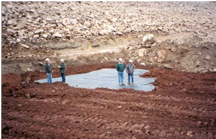
Figure 20.3.3.1-3. Clay cap over the PVC geomembrane.
